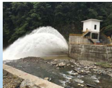
贵州道塘水库
