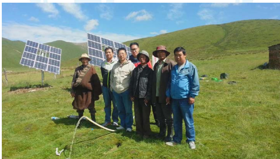
青海省刚察县太阳能牧场供水
